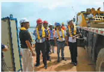
定期现场检查
