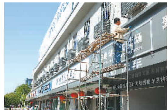
沿街建筑立面重新整修,统一店牌、广告牌样式。(陆金妹 余建文 摄)
