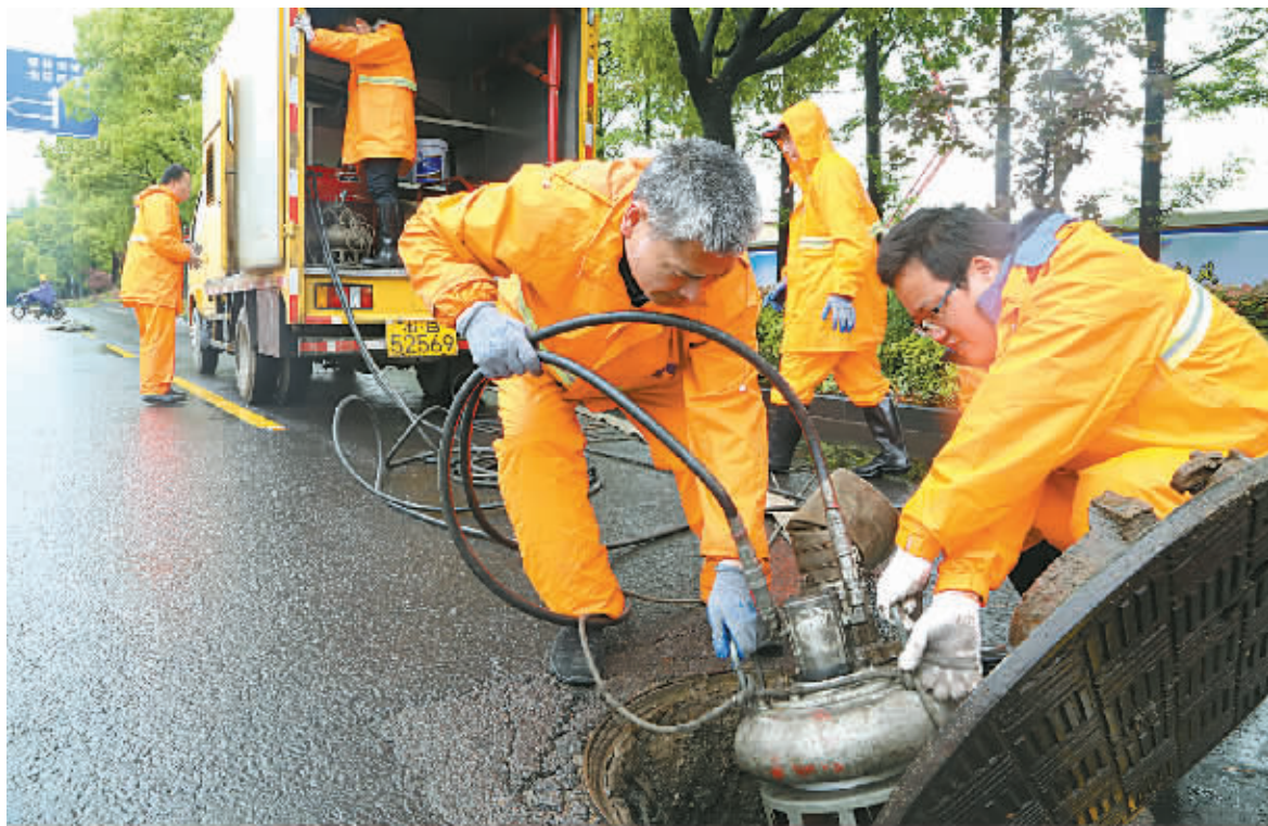
昨天下午,市城管局排水集团排水公司工作人员在环城西路北段开展防汛演练。图为工作人员快速将强排水水泵拆装到雨水井内,实现快速排水。(朱彬彬 单玉紫枫 摄)
