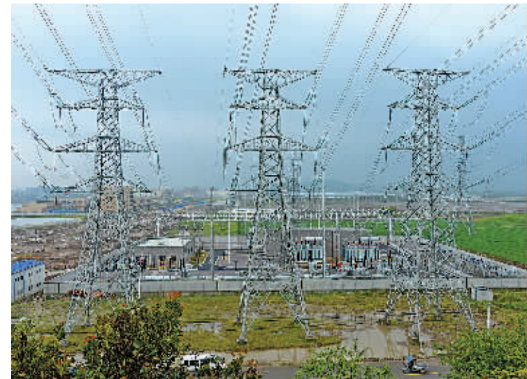
图为220千伏霞客变电站全景图。
