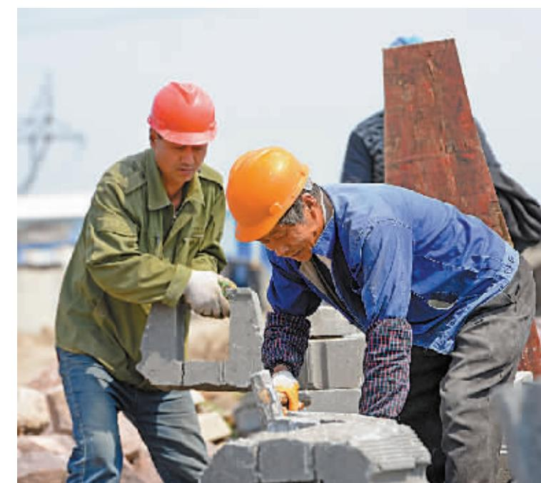
连日来，在鄞州区洞桥镇的荆江堤防维修加固工程Ⅱ标段现场，防洪堤干垒块贴面施工正在紧张有序地进行。据介绍，全长5463米的防洪堤采用堤岸合一双挡墙式结构，除去因水闸、泵
