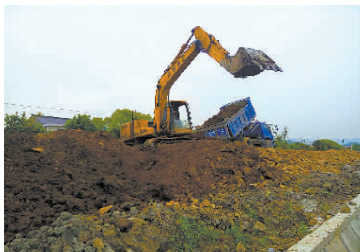
图为郭塘河整治工程施工现场。
