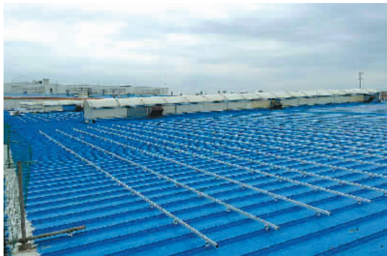
吉利汽车借改造契机,铺设光伏电池覆盖支架,实现面貌、效益“双提升”。(单玉紫枫 刘鹏程 摄)
