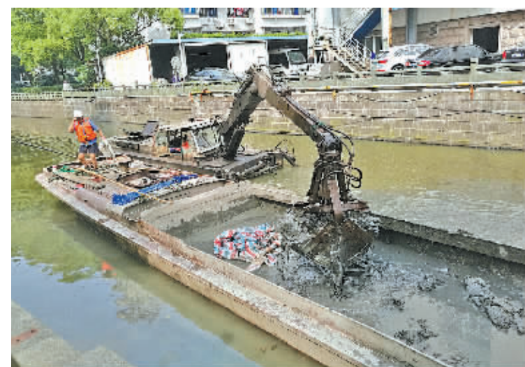
宁东河清淤现场。
