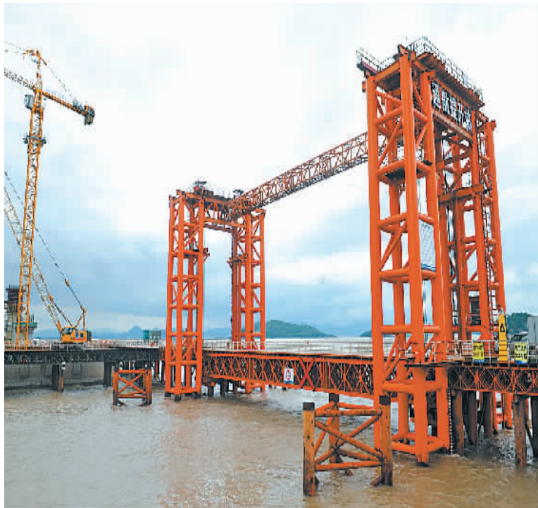
图为正在施工的三门湾大桥及接线工程。(周维强 摄)
