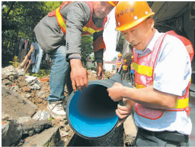
昨天,工人正在宝善路安装雨污分流管道。(徐文杰 摄)
