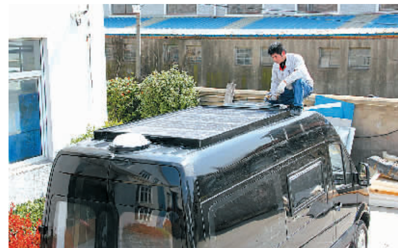
工人在房车车顶安装太阳能发电板。(张超梁 王桂林 摄)
