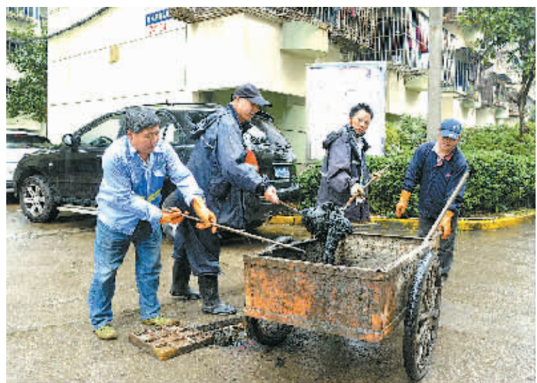
图为昨天下午，江东城区管局市政养护应急抢险班组队员正在徐家社区下水道疏通养护。（记者 陈章升 摄）
