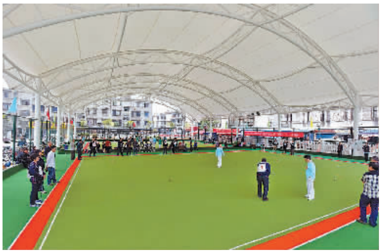
刚刚建成的骆驼街道门球场设施齐全,被老人们戏称为“豪华版”的门球场。
