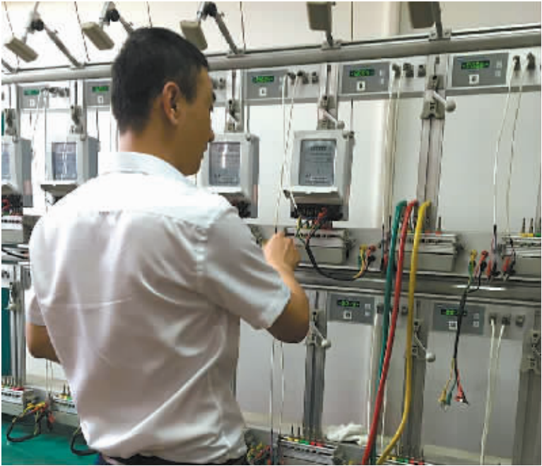
工作人员正在检查电表装置。
