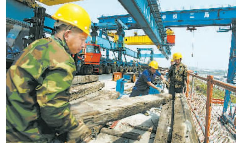
日前，杭州湾跨海大桥杭甬高速连接线公路工程四标段施工人员在为刚转场的提梁机搬运垫木，为该连接线南段架设首片箱梁作准备。该工程投资概算47亿元，全长17.9公里，起点位于余姚市马渚镇，终点接规划的杭甬高速公路复线小曹娥枢纽，计划明年底前建成通车。
