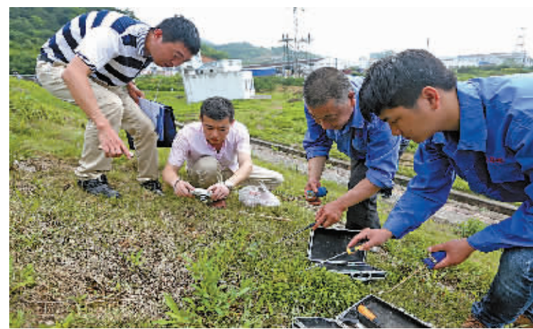
连日来,北仑区水利局联合该区白蚁防治站对全区30座水库大坝展开白蚁灭剿工作,通过生物药剂点杀和诱杀色诱杀的方式灭剿堤坝白蚁,消除水库堤坝安全隐患,确保水库防汛安全。(索向鲁 徐能 摄)
