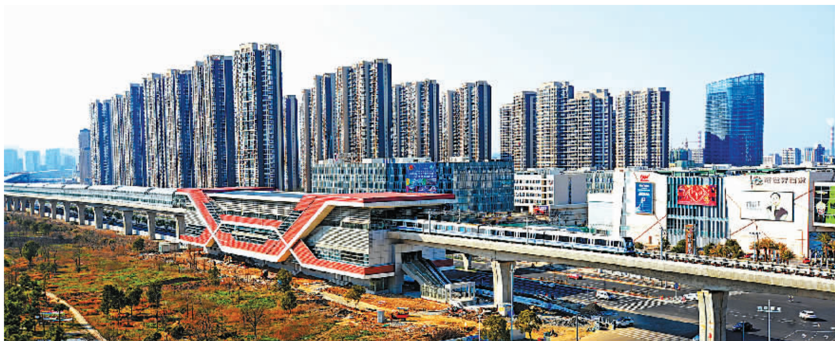
地铁穿越北仑城区。
