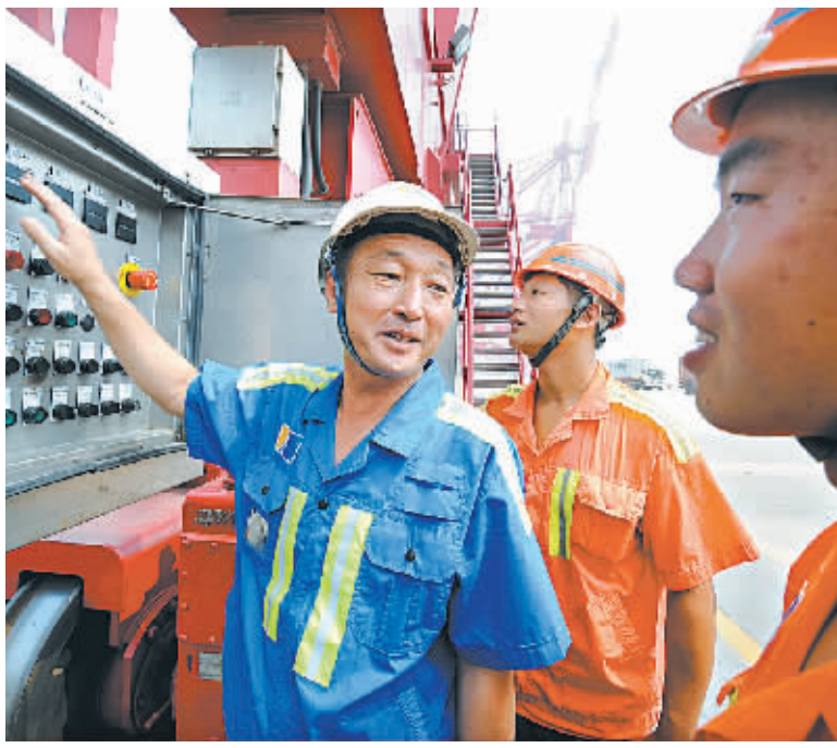
许振超（左）在给工人讲解桥吊控制柜的运行情况（2009年8月19日摄）。
