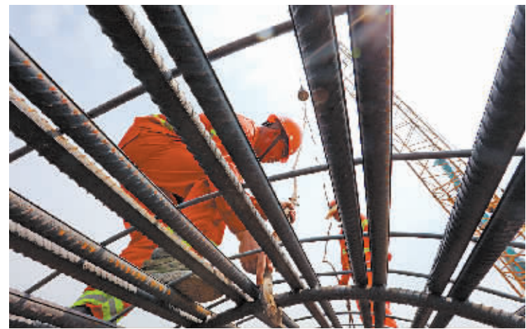
图为奉化江特大桥施工现场。(徐能 摄)
