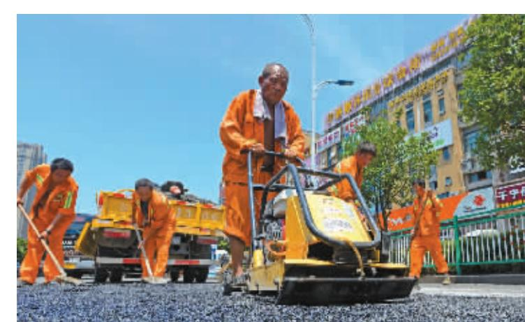
前天中午，在鄞州区四明中路(都市森林段)，市政工人顶着烈日修补破损坑洞。由于受前期台风及强降雨影响，新城区多条道路出现一定程度损坏，该区城管局市政公用管理处立即开展道路“平坦行动”，趁晴好天气抓紧对所有坑洞进行修复，确保市民行车安全。
