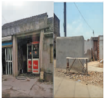
“地下加油站”和违章建筑已被拆除。
