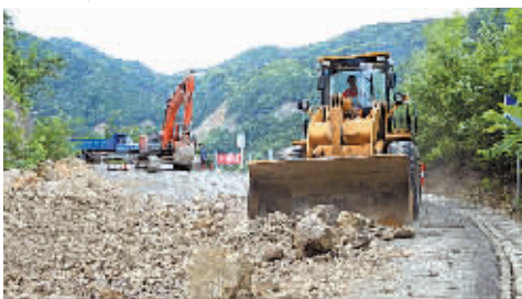
清理山体塌方
