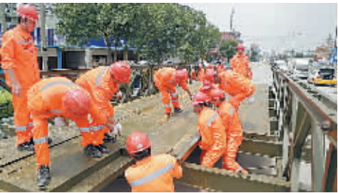
架设应急钢桥
