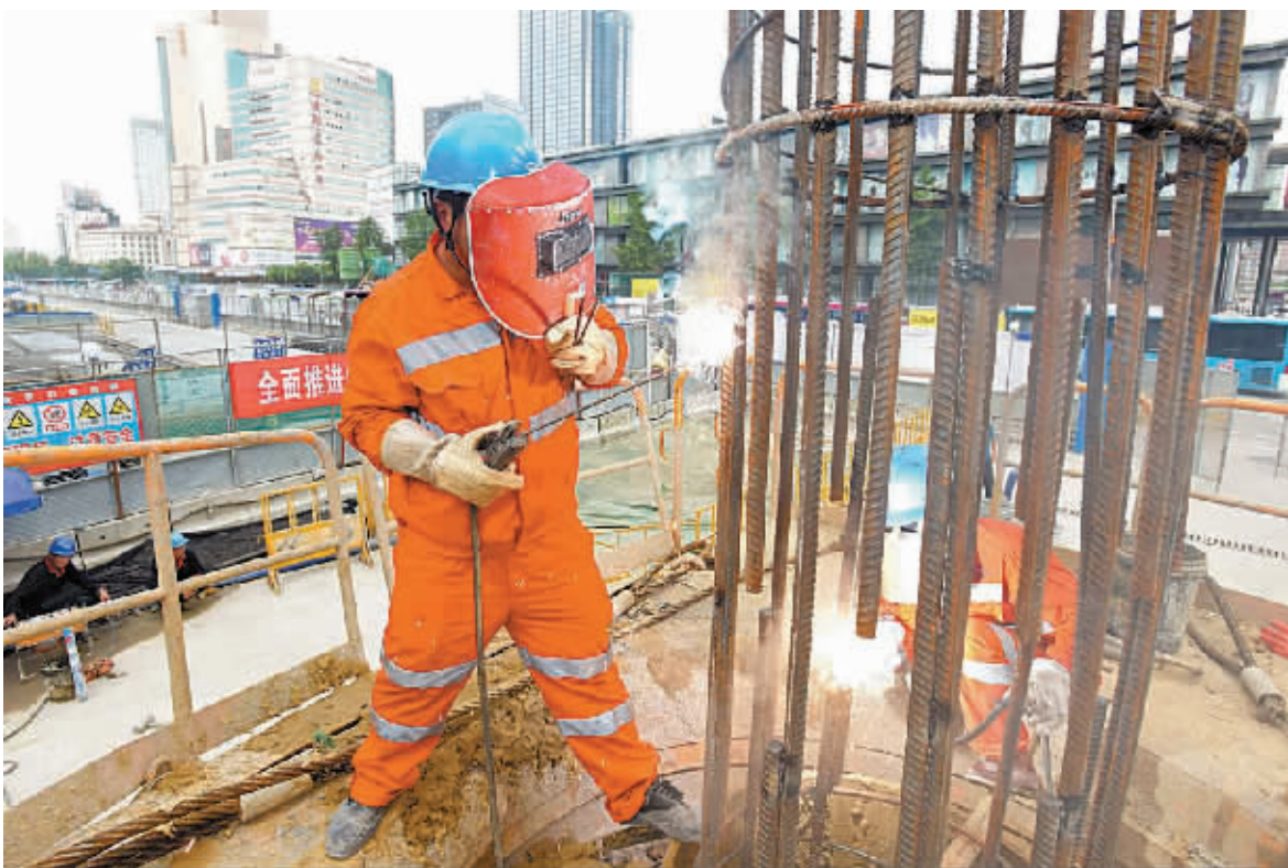
昨天下午, 在海曙区碾闸街地下通道工地, 工人们冒着高温进行基坑围护咬合桩钢筋笼焊接作业。据悉, 中山路综合整治海曙段目前已基本完成管桩铺设工作, 进入道路结构层施工阶段。 (徐文杰 张立 摄)
