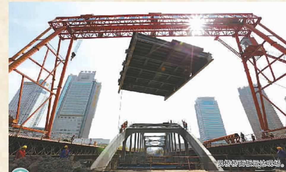
灵桥跨面顶板吊装现场。
