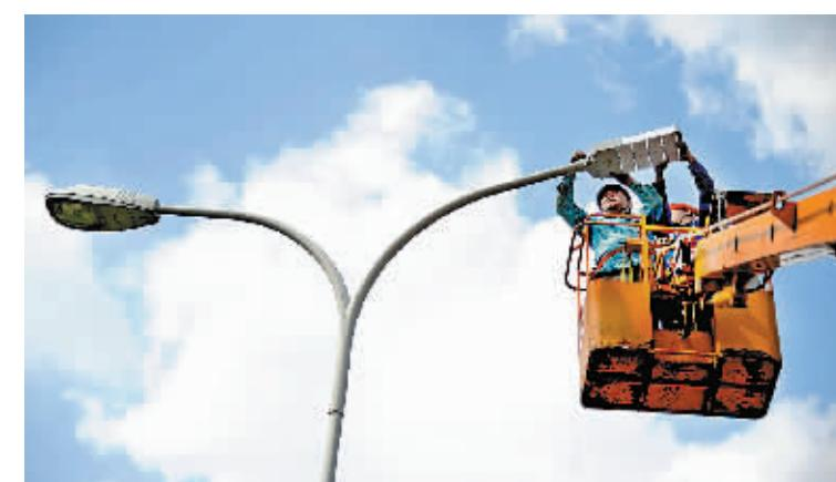
连日来，鄞州区城管局市政公用管理处工作人员不顾高温炎热，在钱湖路上进行路灯改造作业。为进一步推进市政设施的节能减排，该管理处此次将550余套普通钠灯换成LED路灯，改造工作预计本月底结束。届时，鄞州中心城区将实现绿色照明基本覆盖。（记者 徐能 摄）
