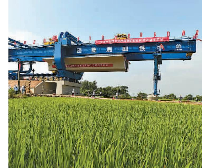
8月8日,中铁四局施工人员在架设西山驿特大桥第一片箱梁。
