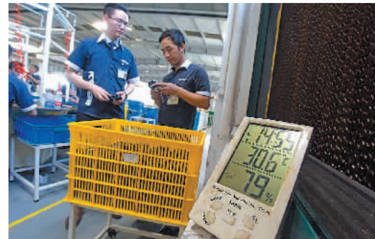
水帘降温系统运作后,车间温度保持在30℃左右。
