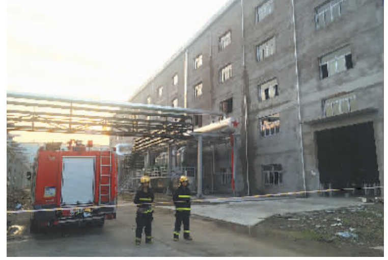
这是8月11日拍摄的事故现场(手机图片)。8月11日15时20分许,湖北当阳市马店矿发电有限责任公司高压蒸汽管道发生爆炸事故,经全力组织搜救,目前已确认死亡21人、受伤5人,其中3人重伤。伤员已送往医院救治,事故现场搜救正在进行。(新华社发)
