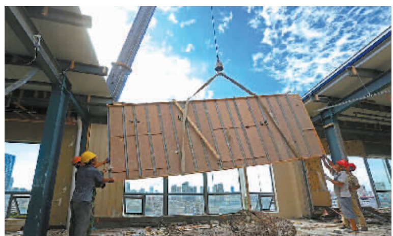
图为工人在拆除美仑丽湾楼顶层违建。(李超 摄)
