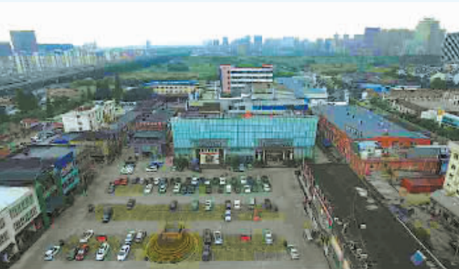
环城西路南段776广场地块
