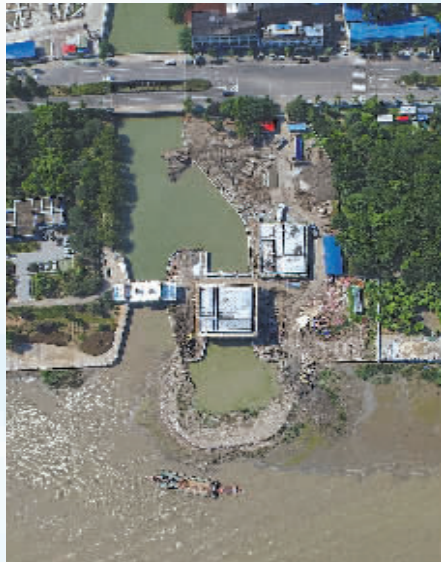
印洪泵强排泵站鸟瞰图
