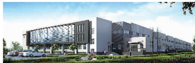
德国玛汀瑞亚宏泽铝制配件（余姚）有限公司的新厂房。
