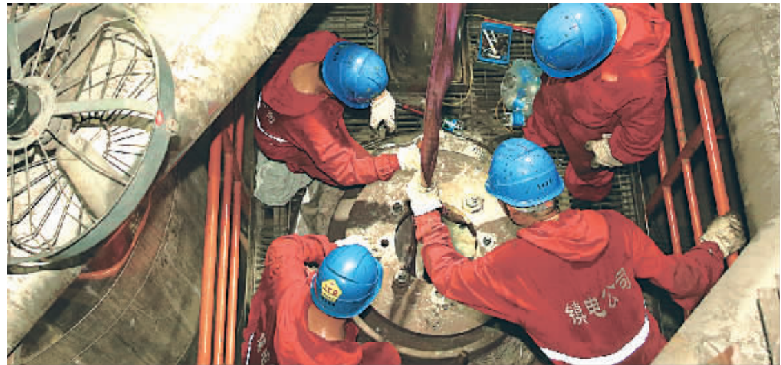
前天,镇海发电公司4号机组蒸汽冷却器不停机捉漏项目经过3天连续抢修取得成功。该公司维修热机二班职工冒着现场80℃左右的高温,在如同“烤箱”般的狭小空间里轮流作业,保证了机组安全、稳定发电。(董英姿 严龙 摄)
