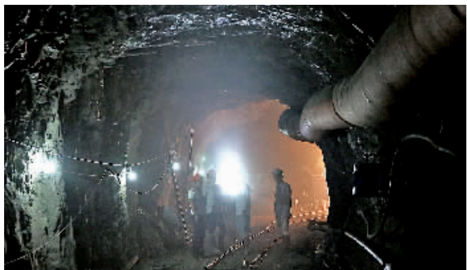
杨资情和工友一起走进隧洞准备巡查。
