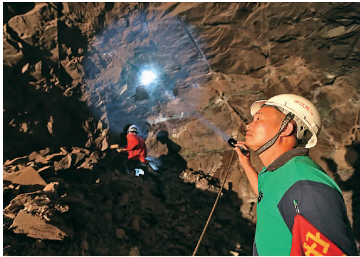
爆破后,安检员正在检查隧洞内是否安全。
