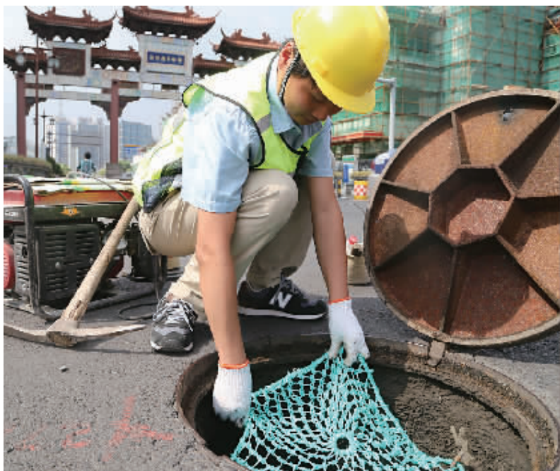
图为工作人员在铺设“防坠网”。
