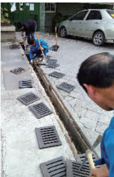
小区物业人员在维修排水沟。（陈朝霞 摄）
