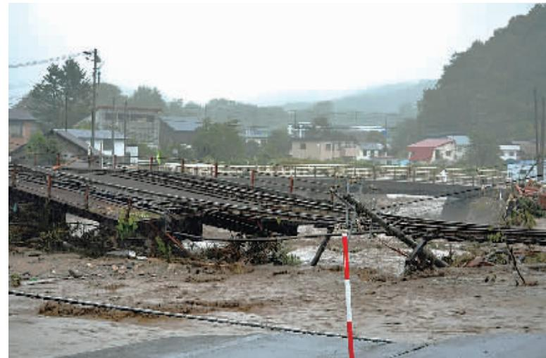
日本《十胜每日新闻》8月31日提供的照片显示,日本北海道新得的一段铁路遭到洪水的破坏。
