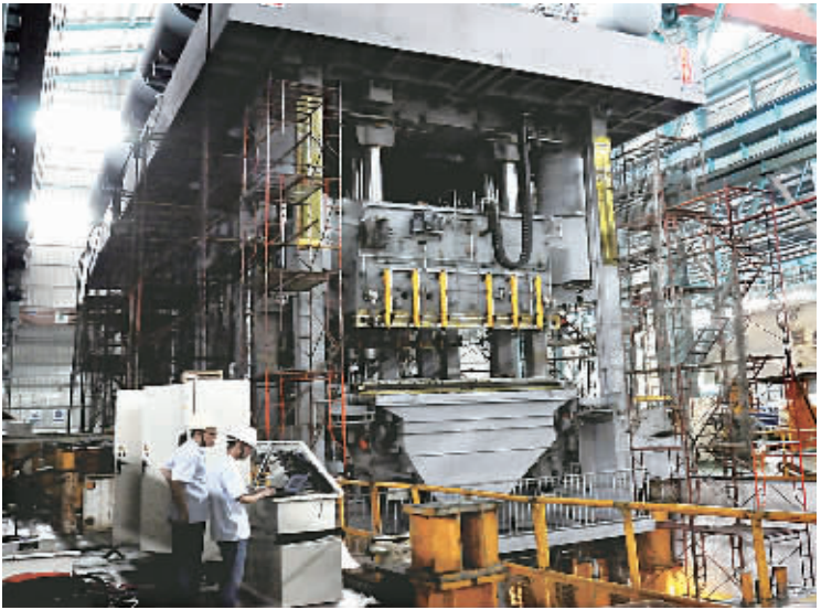
工人在检查大型汽车冲压线运行情况。（图片由金丰公司提供）
