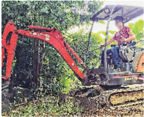
经过两周的农场生活，周庭伟已能熟练操作挖掘机。（受访者供图）
