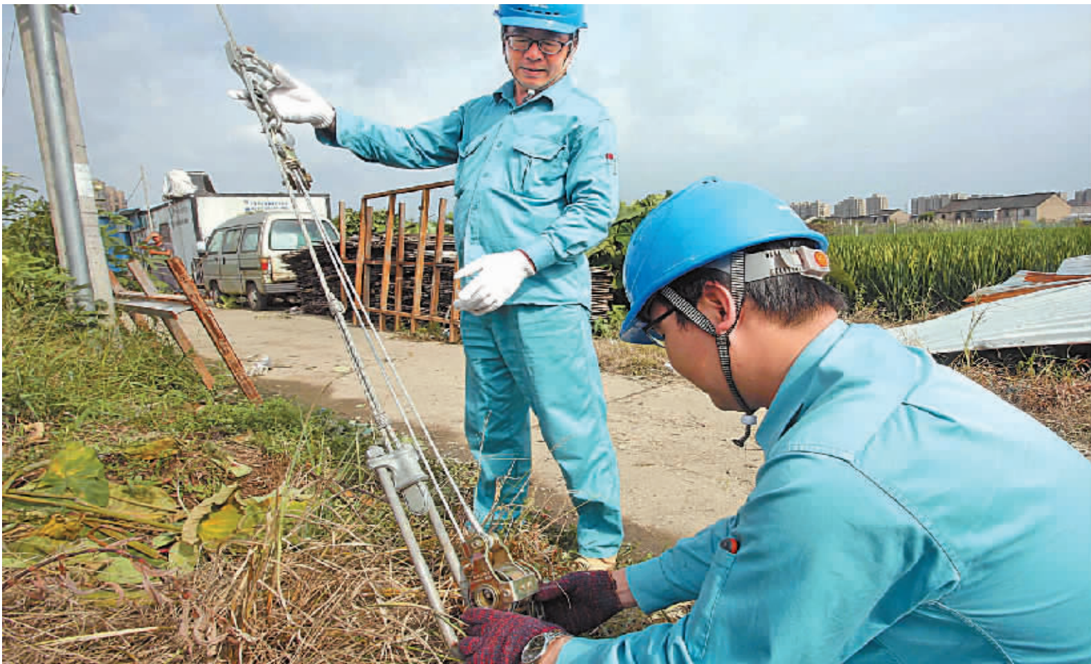
昨天下午，鄞州供电公司集士港供电所线路二班员工在集士港村50号公用变终端线路进行加固处理。（徐文杰 胡春华 摄）
