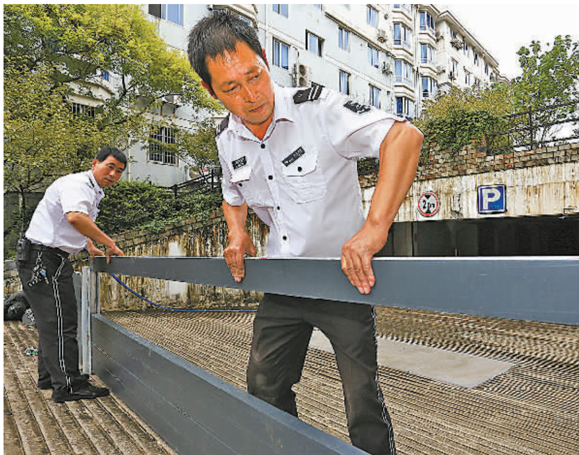
上图：昨天上午，镇海区招宝山街道金桂花园小区地下车库门口，保安正在将一块块铝合金板插入车库进出口两侧的卡槽内，搭建一面高约80厘米的挡水板。该小区在街道城建中心的帮助下安装了这种阻水“法宝”，在抗击14号台风“莫兰蒂”期间，小区地下车库没有出现进水情况。 (徐文杰 沈颖 摄)
