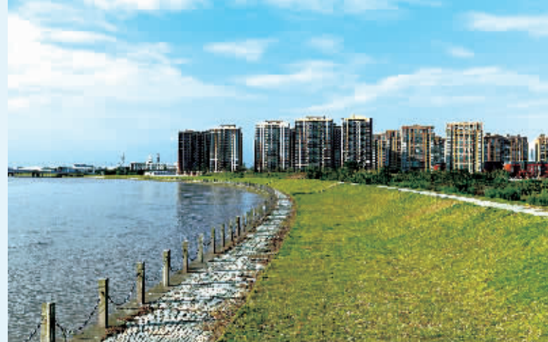
奉化江堤防鄞州城区段。
