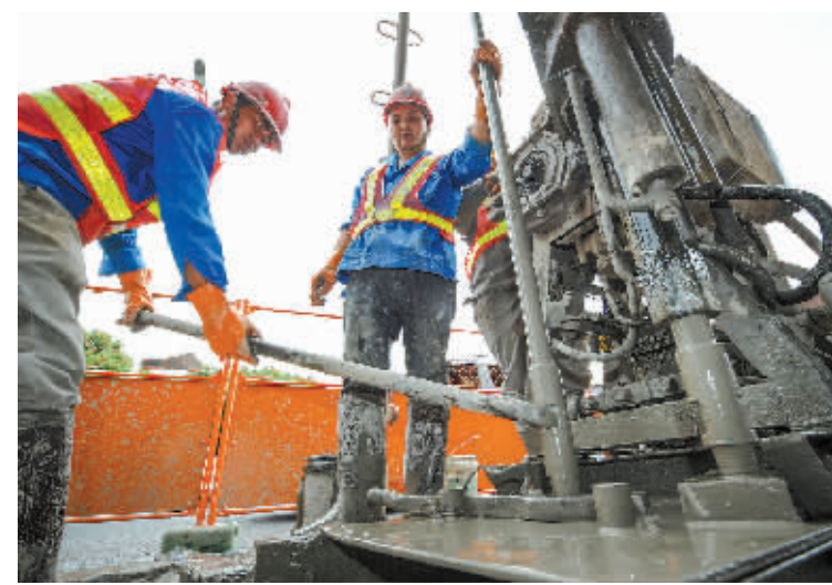
昨天上午,宁波工程勘察院施工人员正在世纪大道进行地质勘查作业,为即将展开的市重点建设项目——世纪大道快速路建设提供地质数据。(记者 严龙 摄)
