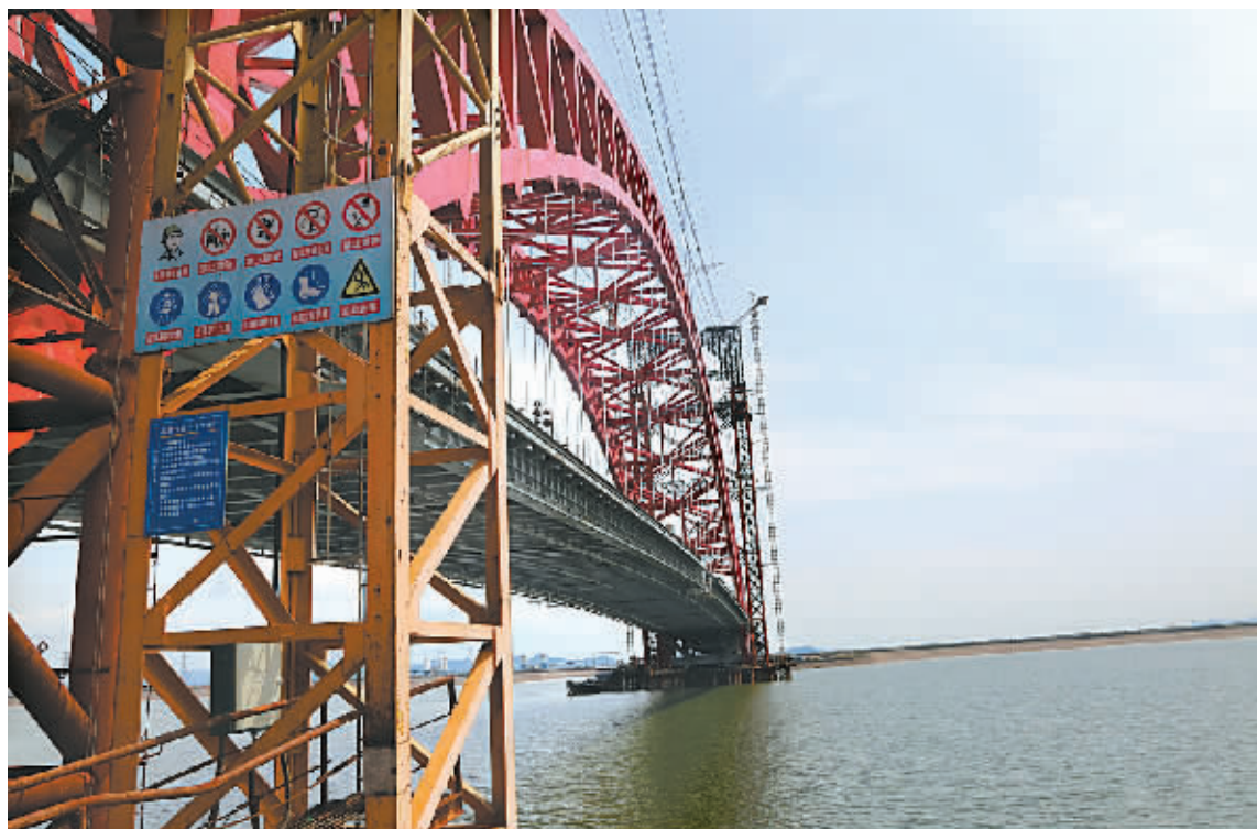
春晓大桥主梁合龙后实景。
