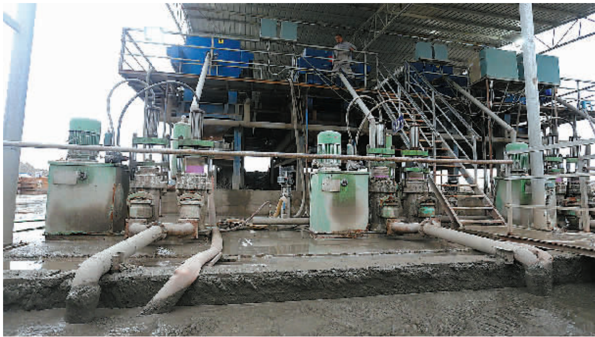
宁波机场高架建设工地,工人正在进行泥浆固化处理。
