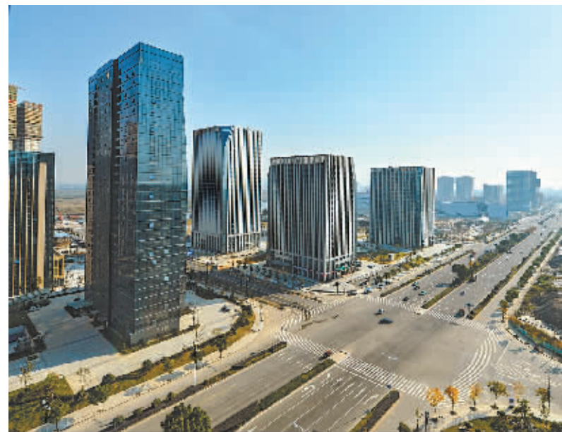
慈溪新城大道两侧,充满现代气息的高层建筑,展现未来都市景观。
