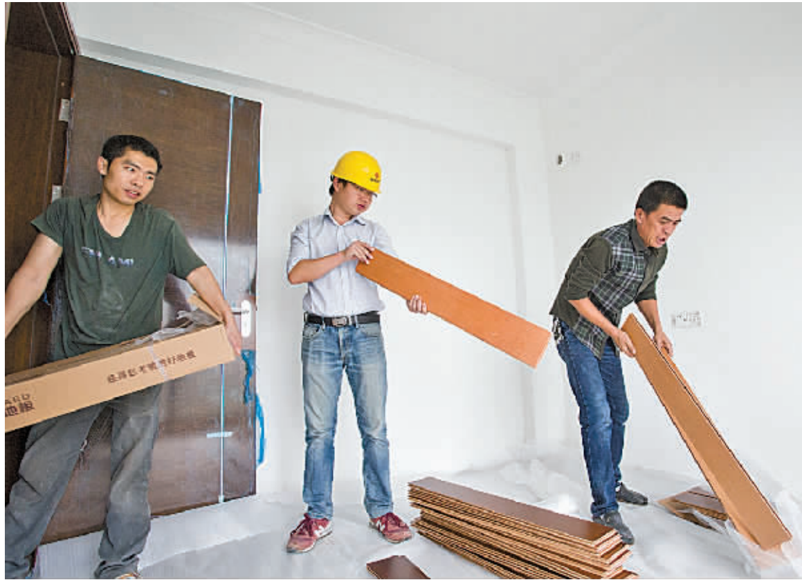
一家精装修的房企正在组织人员进行装修施工。
