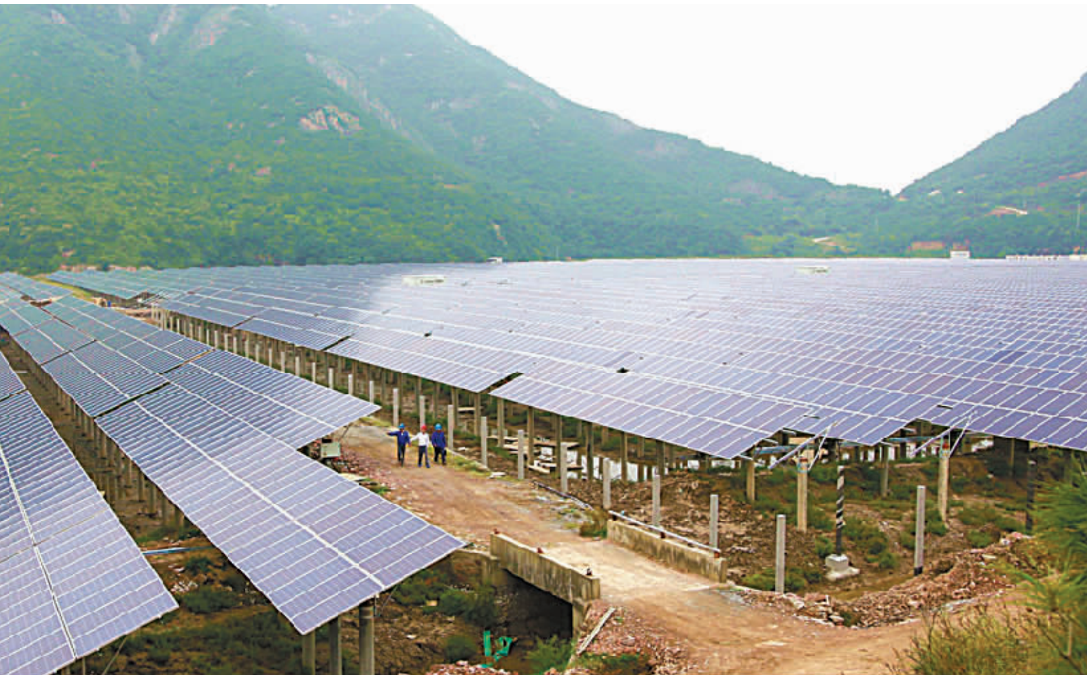
工作人员在检测调试光伏电站并网设备。
