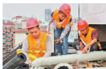
城管供水职工正在安装防冻保暖装置。(魏光华 摄)
