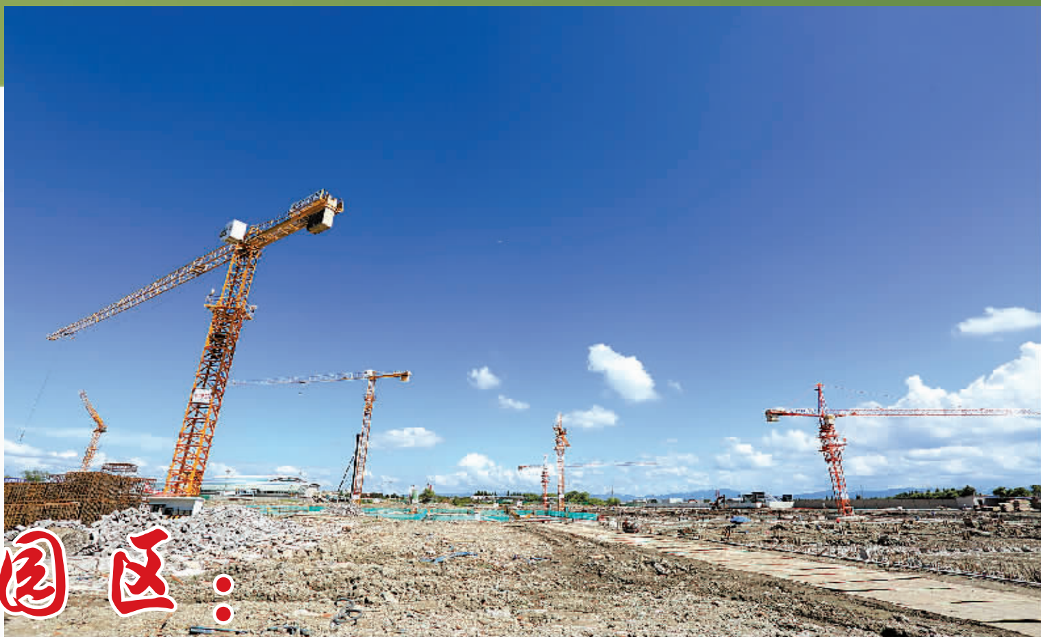
机场三期扩建工程现场
